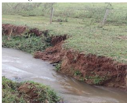
Figura 2A. Ausência de APP; assoreamento do talvegue do córrego
