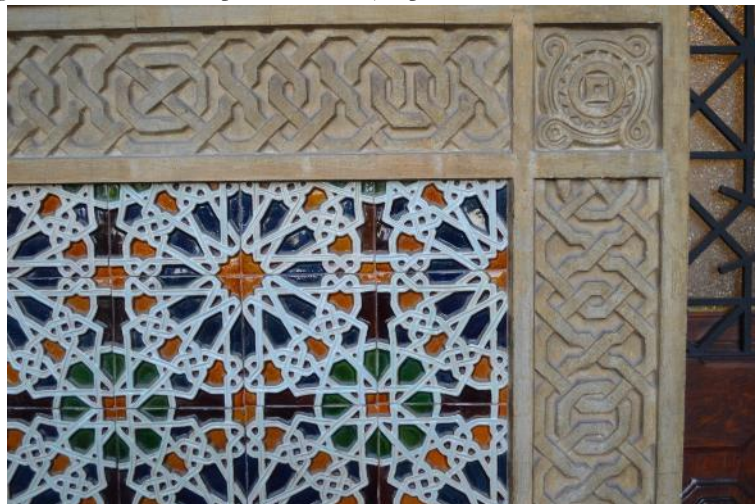
Figura 6 — Detalhe do painel de azulejos policromáticos do Pavilhão Mourisco
